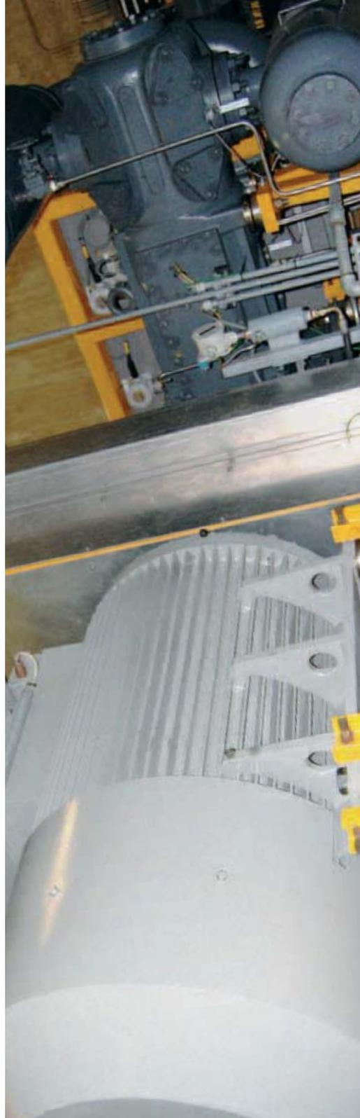
Der VLT® HVAC Drive wurde auch für den Betrieb von Scroll- und Schraubenverdichtern angepasst. Durch die Drehzahlregelung lässt sich die Kälteleistung eines Verdichters exakt an den Bedarf anpassen.
